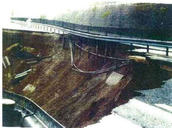
写真 2.4.10 甘木地区路面崩壊状況 19)
