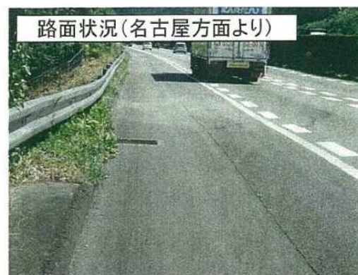
写真 2.4.4 災害箇所の舗装クラック 19)
