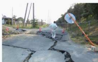
写真 2.4.7 東関東自動車道潮来地区の被害状況(側道部) 8)
