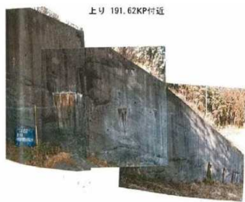
写真 2.4.3 崩壊箇所ののり尻擁壁の状況 19)
