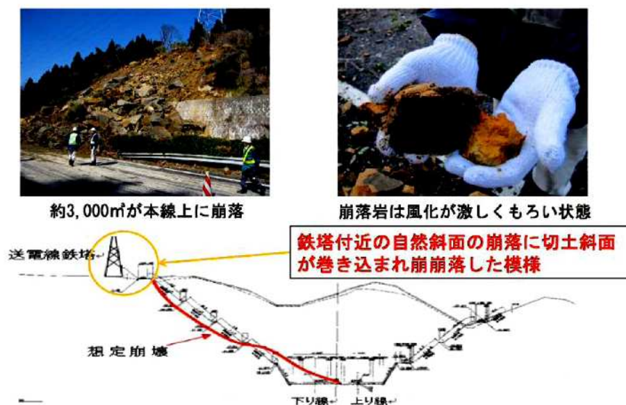
写真 2.4.9 常磐自動車道いわき地区の切土のり面の被害状況 8)
