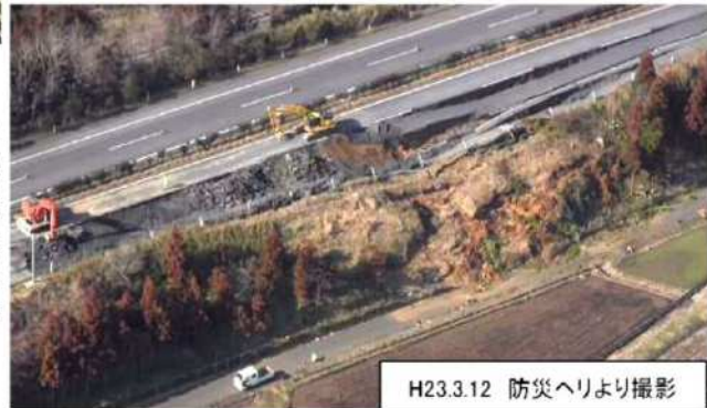
写真 2.4.5 常磐自動車道那珂地区の被災状況 8)
