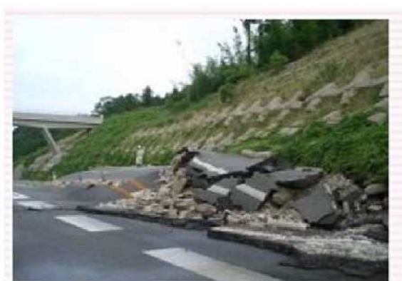
写真 2.4.13 玉造地区地すべり発生 路面状況 19)
