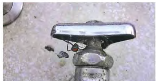
写真52. 校舎の外の水道蛇口 (左の写真拡大)
