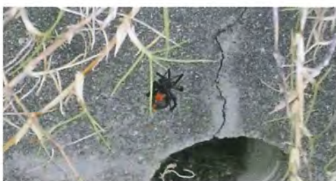
写真36. 水抜き管 (左の写真拡大)
