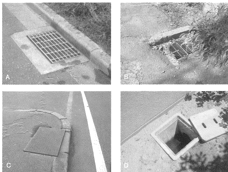
図3. 雨水樹の種類
