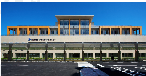
写真① 国立障害者リハビリテーションセンター病院
