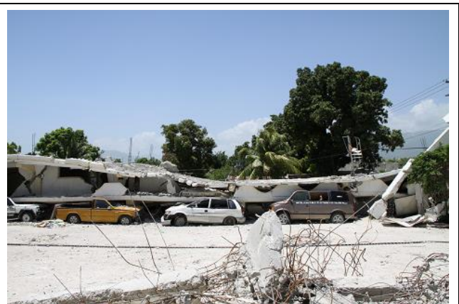
写真①ハイチ地震でサンドイッチクラッシュした建物
