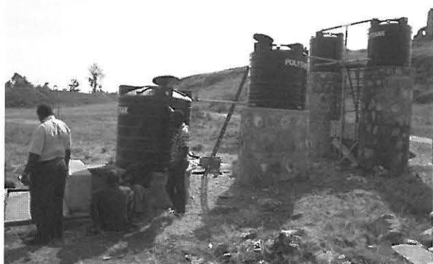
図8 水売り人専用の浄水装置
