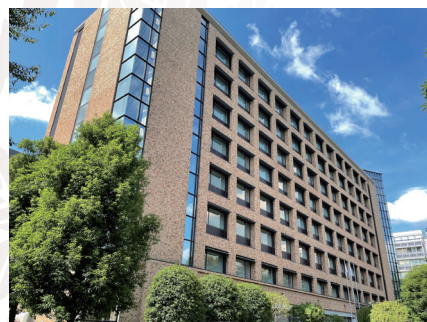
写真1 国立保健医療科学院本館棟 全景
