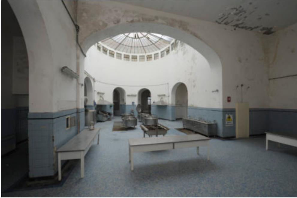
写真 1-5 旧マッジャーノ病院の調理場
