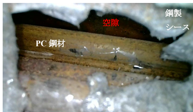
図 2.1.3 グラウト未充填シース内のPC鋼線
