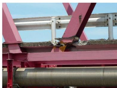
(b) 木曾川大橋の斜材の破断
