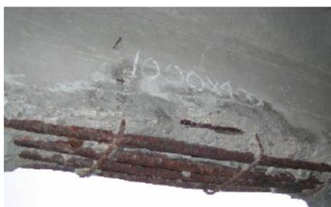
(a) 朝丸橋の主桁の鉄筋腐食
