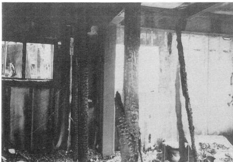
写真10 魚崎北町5・6丁目地域（S造建物の内部）
