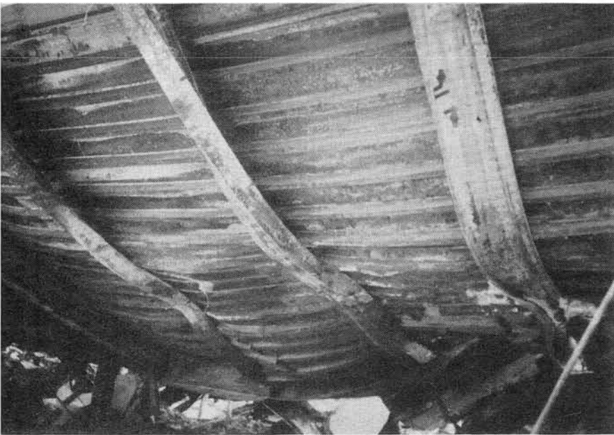
写真36 水笠西公園周辺地域 (S造建物天井部分)
