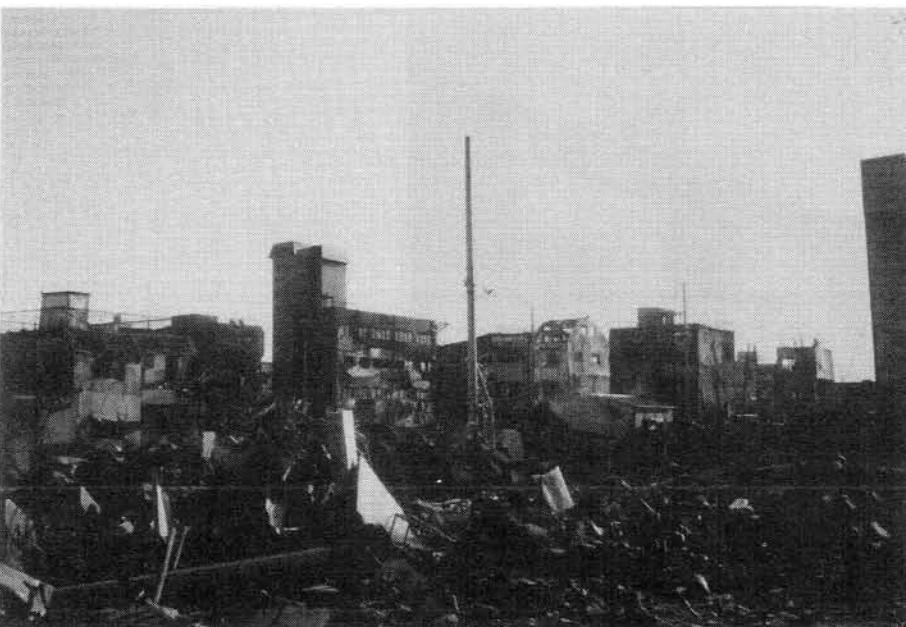
(R C造建物の被害)
