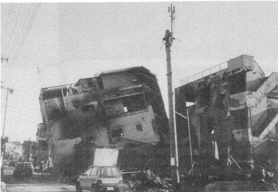
写真39 水笠西公園周辺地域（R C造建物倒壊後火災の被害）
