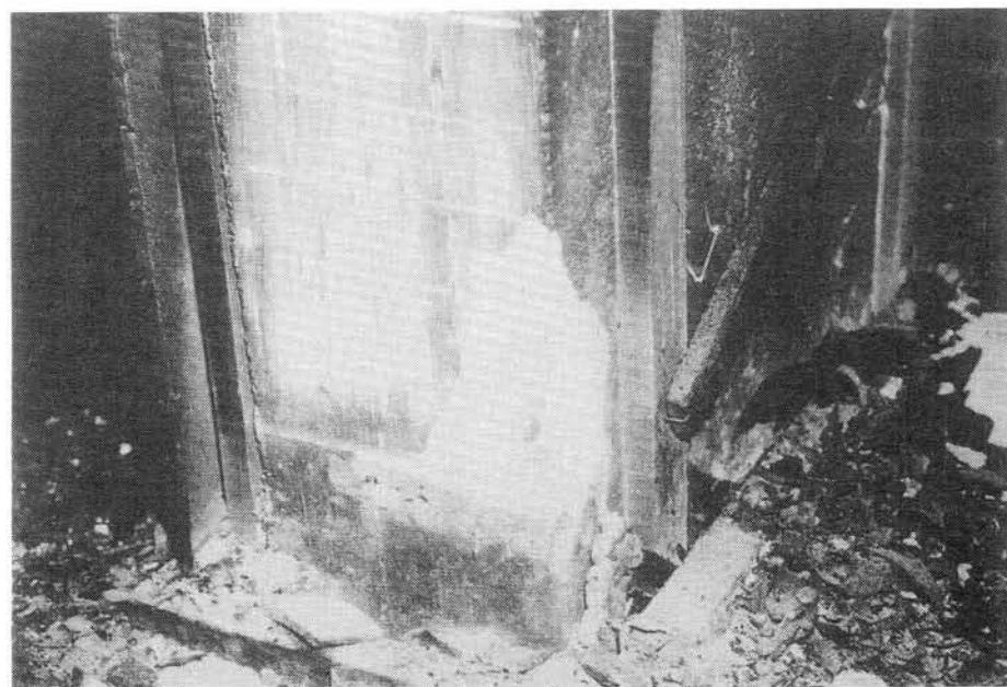
写真2.23 袖壁部分の火害状況（1）
