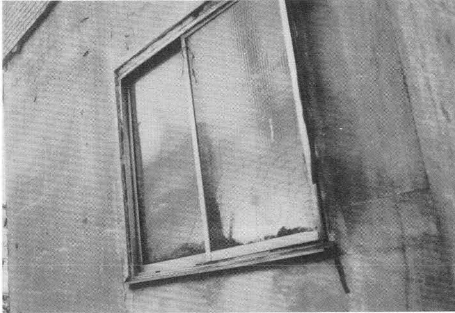
写真38 水笠西公園周辺地域（R C造建物開口部）
