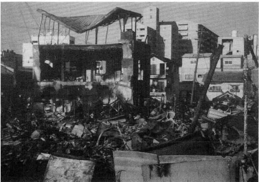
( S 造建物の被害 )
