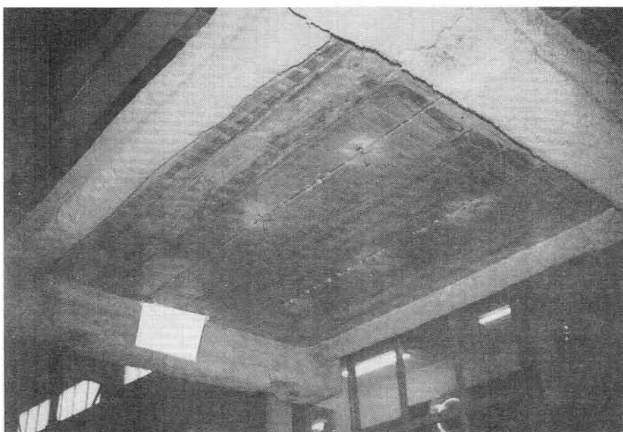
写真3.2 複合板（フラット・デッキ）の加熱前の状況
