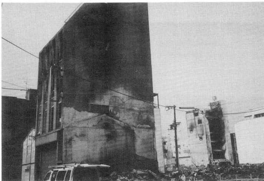
(R C 造建物の被害)
