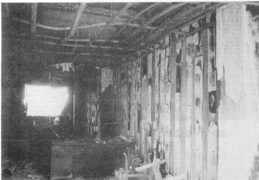
(RC造建物の内部)
