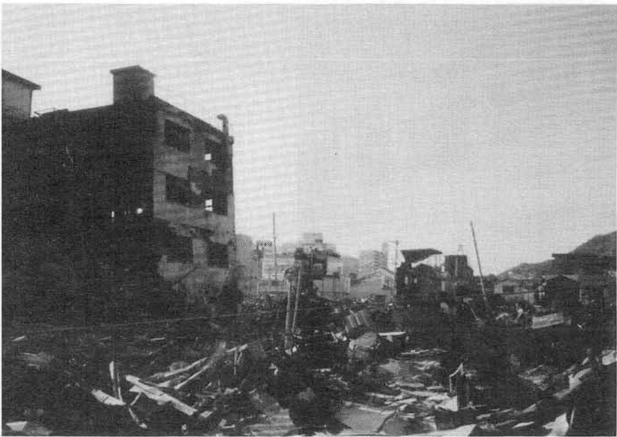
( S 造建物の被害 )
