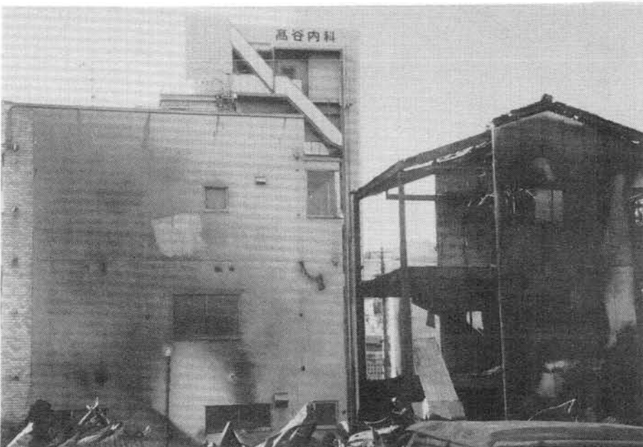
(R C造建物の被害)
