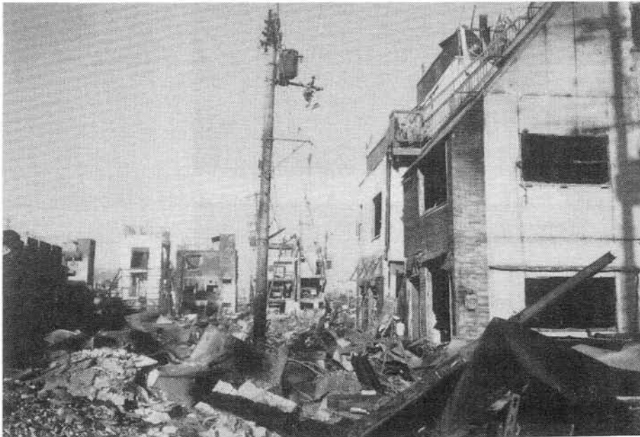
(S造建物の被害)
