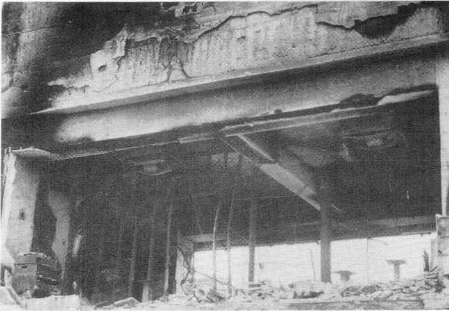
(RC造建物の内部)
