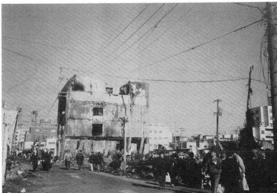
写真26 長田区高橋病院周辺地域 (S造建物の被害)
