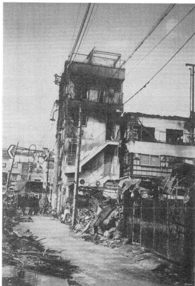
写真4 青木駅南地域（4階S造建物）
