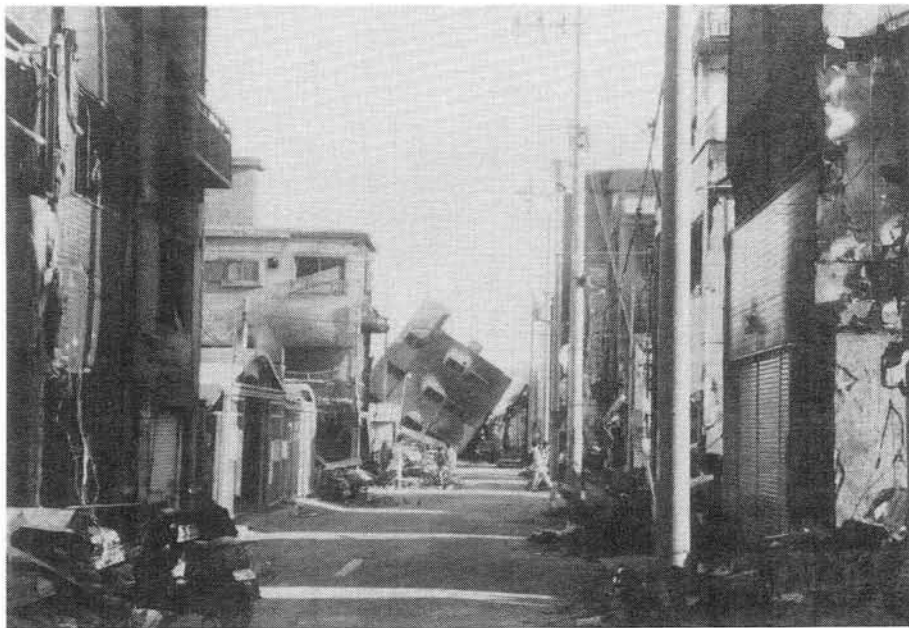
(RC造建物の倒壊後火災の被害)
