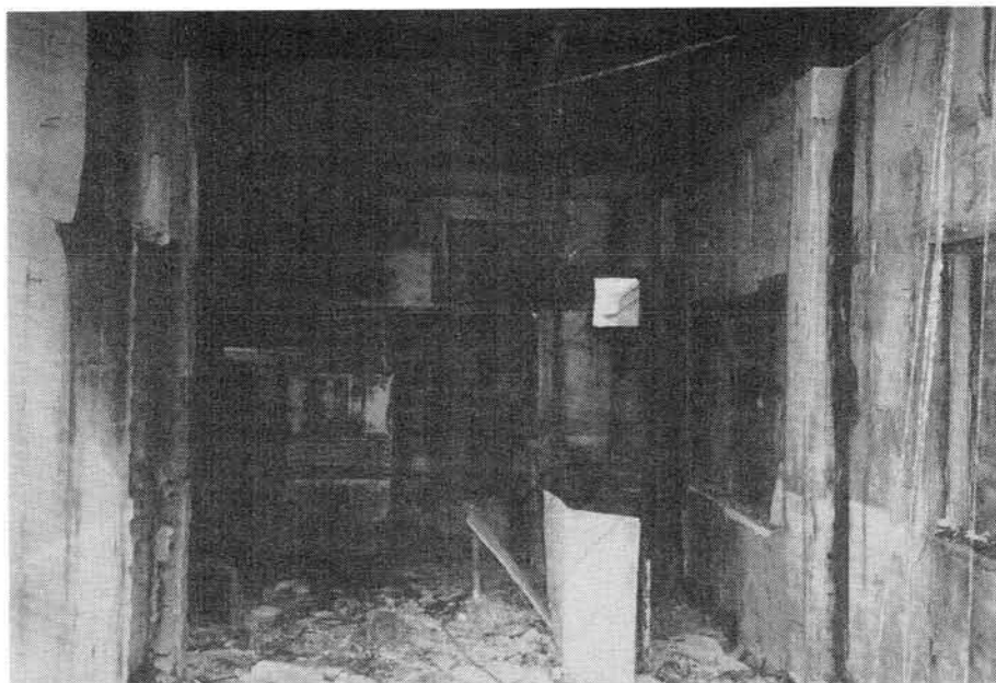
写真6 青木駅南地域（写真4の建物の内部状況）
