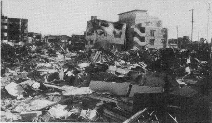
( S 造建物と R C 造建物の被害 )
