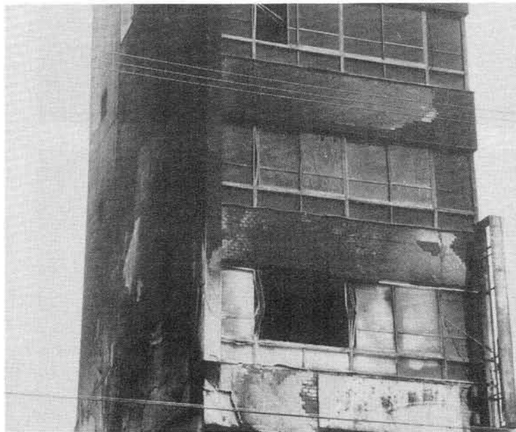
（前のRC造建物の近影）
