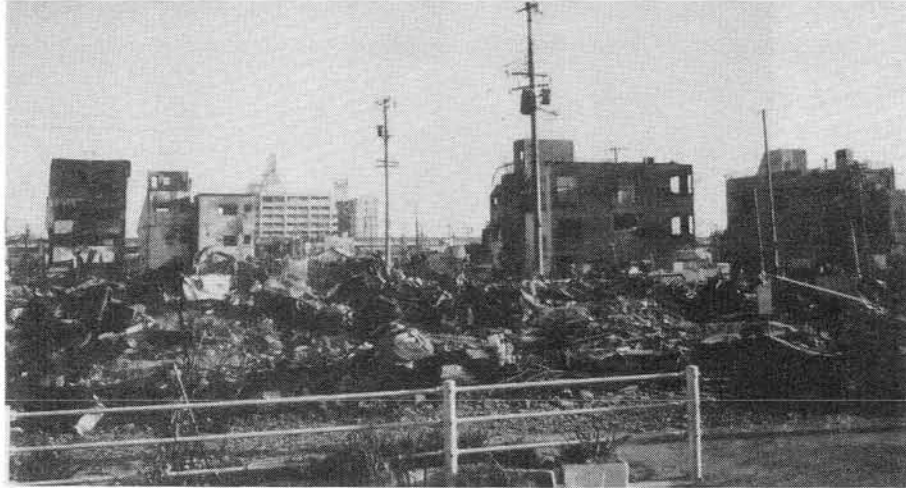
(RC造建物の被害)
