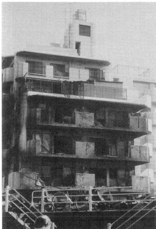
写真31 長田区高橋病院周辺地域（RC造建物の被害）
