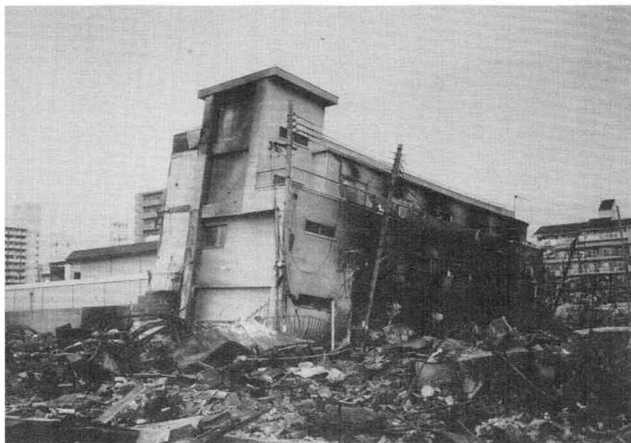
(RC造建物倒壊後の火災による被害)
