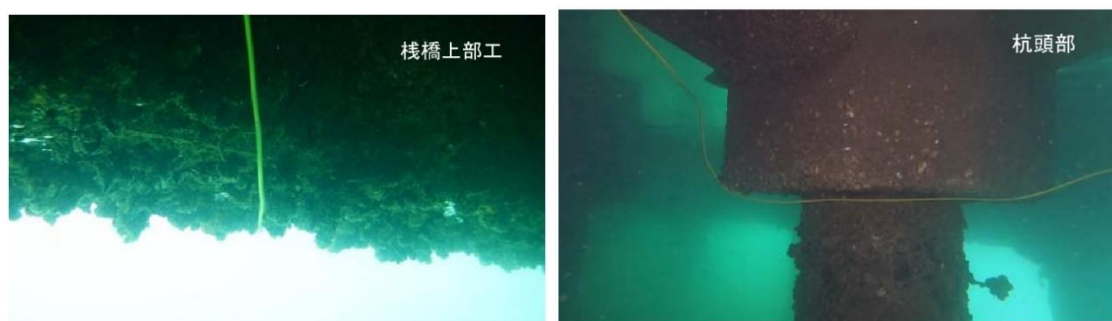
図4.7 水中ロボットのケーブルの港湾構造物へのひっかかりの状況
