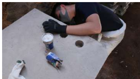
図 3-25 プラ容器を型枠として使用
