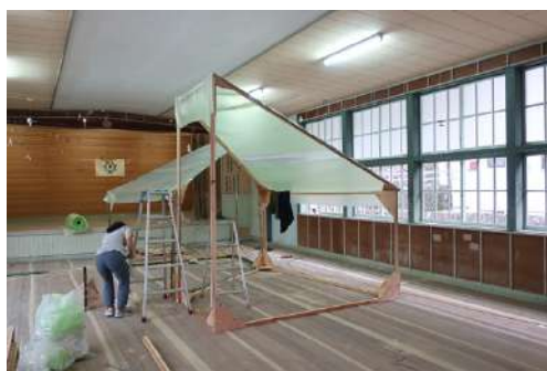
写真 3-8 木材による原寸大試作
