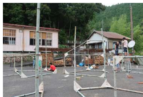
写真 3-14 土台に柱を立てていく
