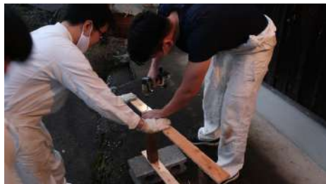
図 3-19 端材で型枠をつくる
