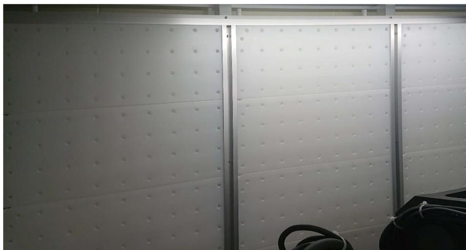
図 3.11 恒温室の水冷壁面
