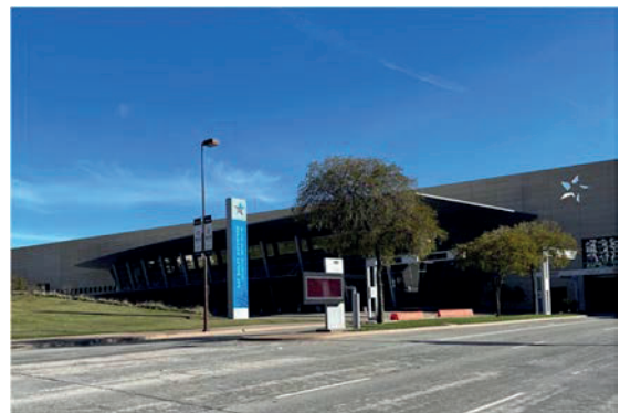
図 1: ダラスコンベンションセンター
