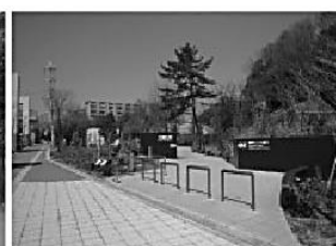
写真 4-11 完成した柴原口改修
