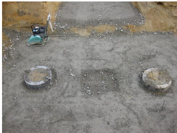
図 3.1 杭頭周辺部の状況
