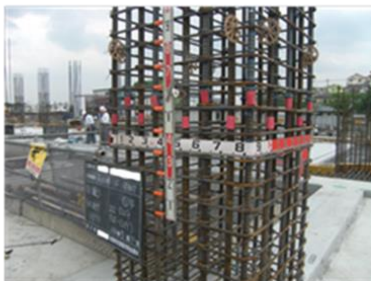
図 1.3 配筋検査写真の例
