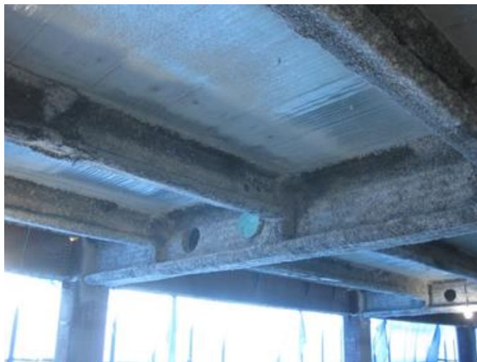
図 4.21 ロボットによる吹付け後の状況
