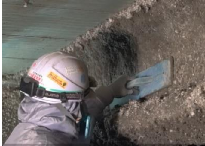
図 4.24 表面押さえ作業
