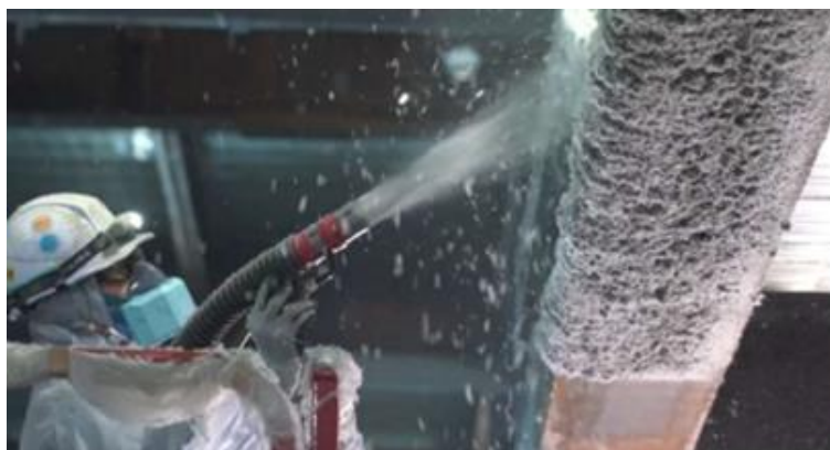
図 2.7 技能工による耐火被覆吹付け作業
