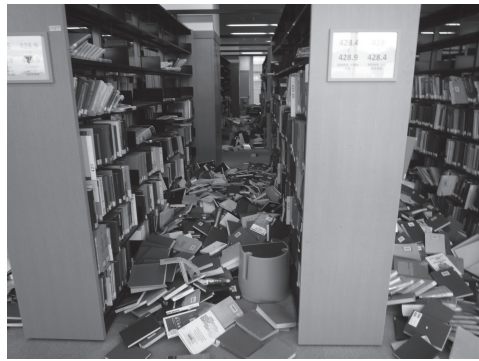
写真1 A棟4階学習用図書の落下被害
