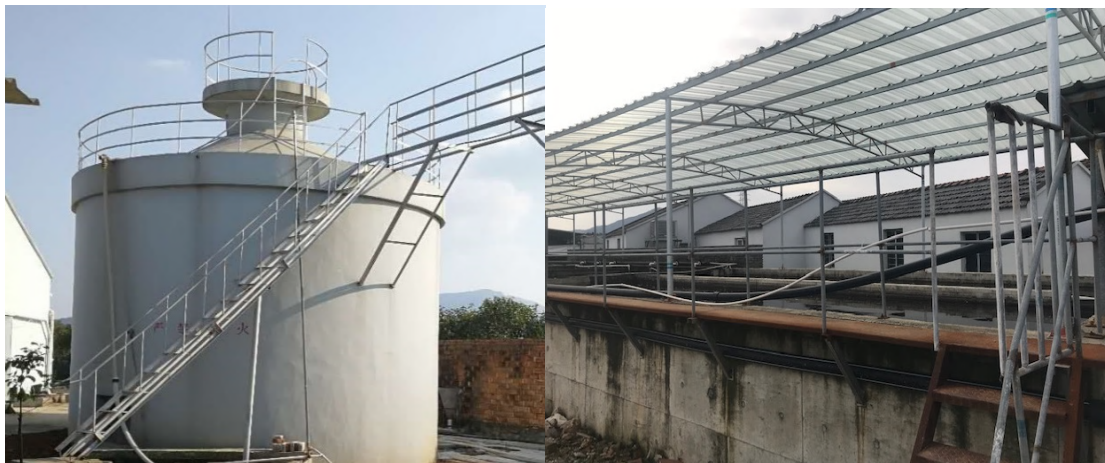
図 1 Z 市のある養豚場の高温メタン発酵施設（左）と污水处理施設（右） （2017 年 4 月(左) 2019 年 2 月(右) 第一筆者撮影）
