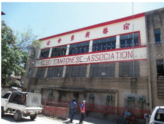
写真1：セブ広東会館の建物
