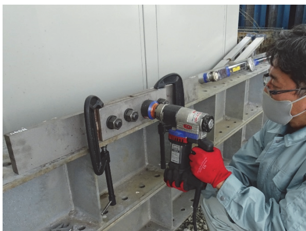
(a) 予備締め（予備締め専用電動レンチ）
