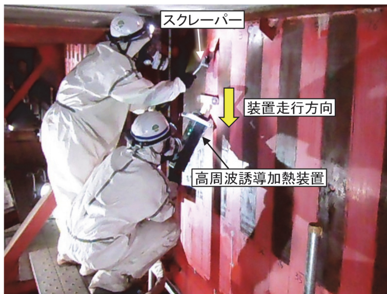
図-2.1 高周波誘導加熱による塗膜剥離状況
