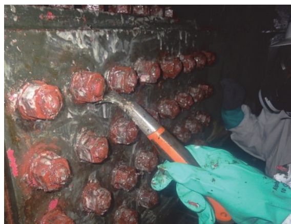
(b) 塗膜剥離剤工法
