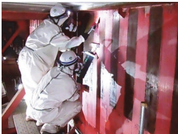
図-1.4 IH 式塗膜剥離工法の施工状況
