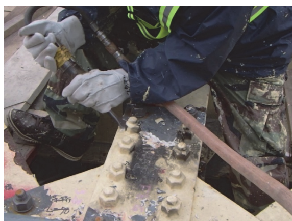
(a) 動力工具工法（エアハンマー）
