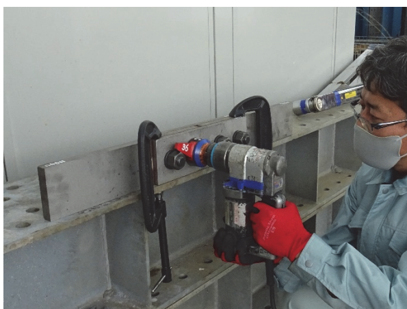
(a) 一次締め（一次締め専用電動レンチ）
