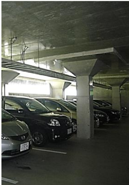
Photo2. 2. 2 駐車場のフラットスラブ構造の例
