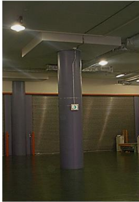
Photo2. 2. 1 倉庫のフラットスラブ構造の例
