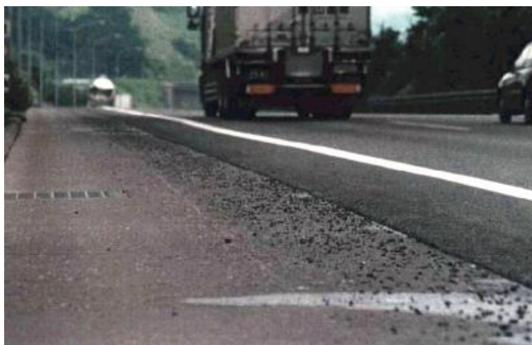
写真-1.2 チェーン規制後の骨材飛散状況 10)
